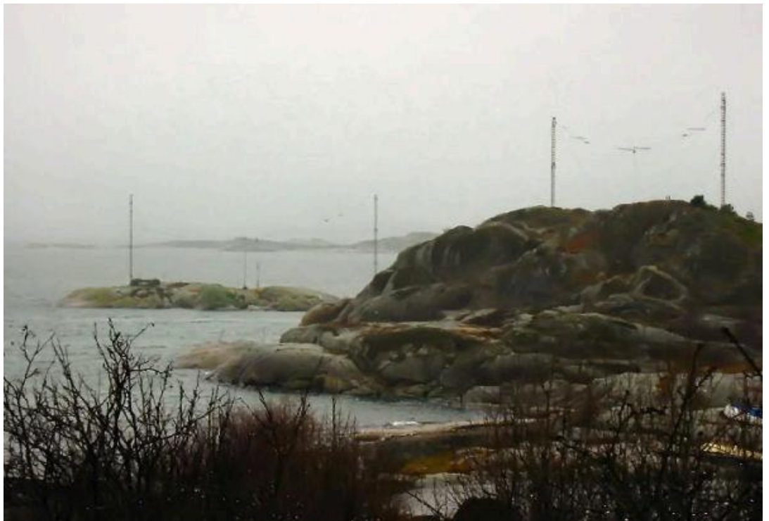
Ett mottagningsannex med antenner i diversitet, dvs dipoler för rymdvåg och vertikaler för markvåg (Arne Ahlström).
