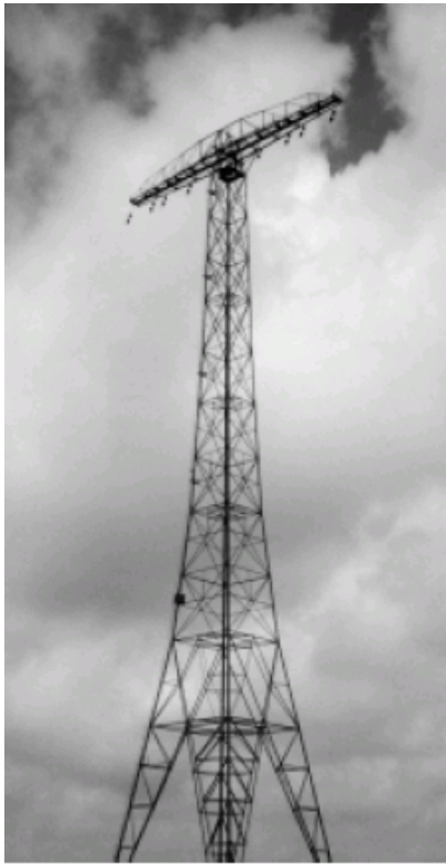
Ett av antenntornen på SAQ, Varberg Radio i Grimeton (Audionen).
